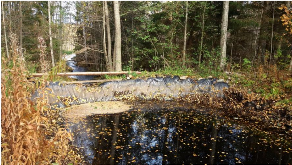
Kuva 8-3. Jalaksenkosken muovilla peitetty maapato (kuva Jouni Liukkonen).
