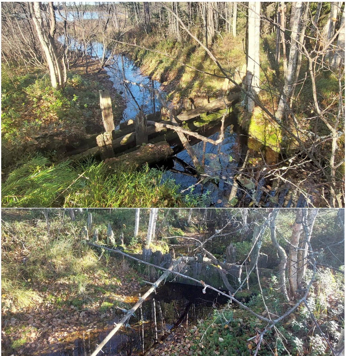
Kuva 14. Pato Latvalammen alajuoksulla. Kuvat: Esa Heikkilä
