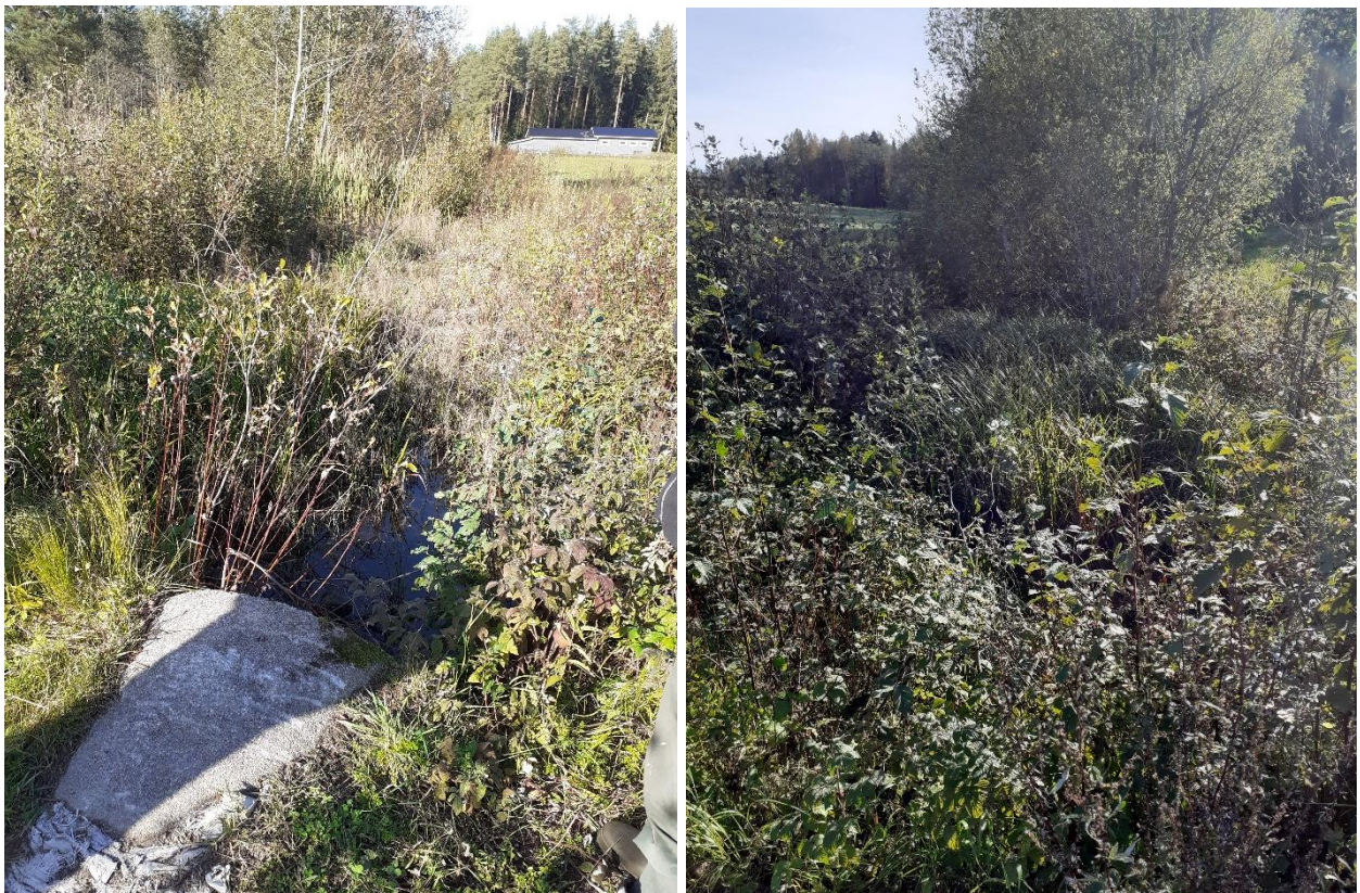
Kuva 35. Lehenpohjassa tien alla on betoniputki, jonka kautta Avojärveltä tulevat vedet kulkeutuvat.
